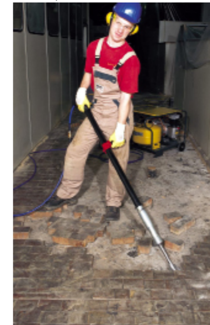
Déposer du carrelage
