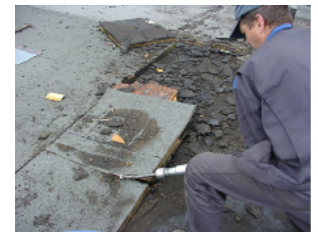
Pré découpe des plaques d'isolation
