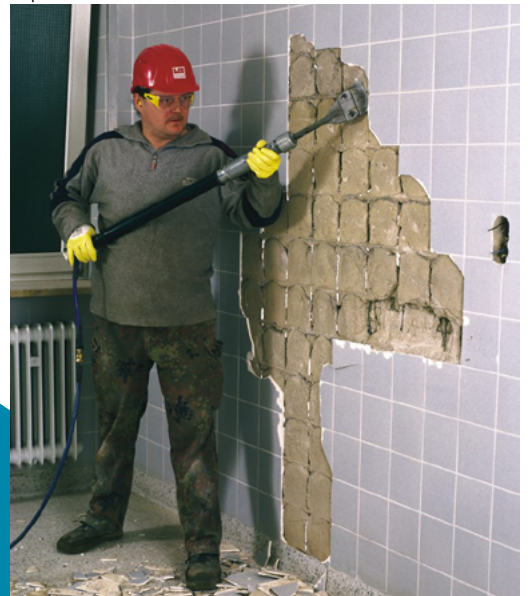
Déposer un revêtement carrelé
