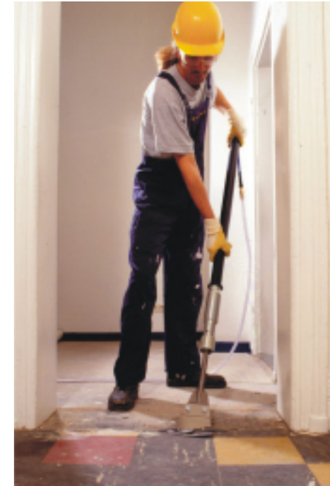
Détacher et découper des revêtements souples
