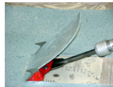
Détacher et découper des revêtements souples
