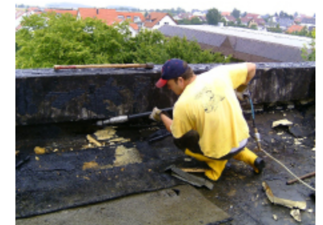
Découper et enlever les plaques d'isolation
