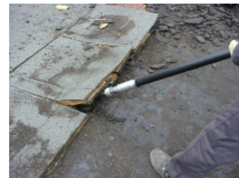
Enlever des dalles en PVC
