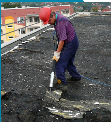
Enlever du bitumeux
